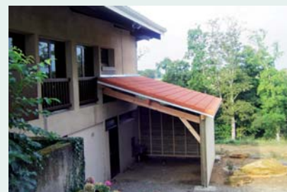
Construction d'un appentis à côté de la salle des fêtes
