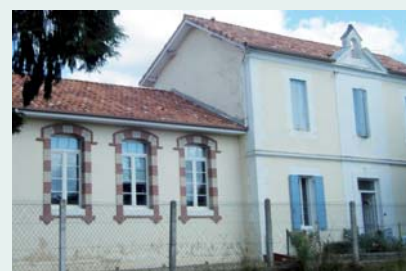
Travaux de toiture à l'école et au logement attenant
